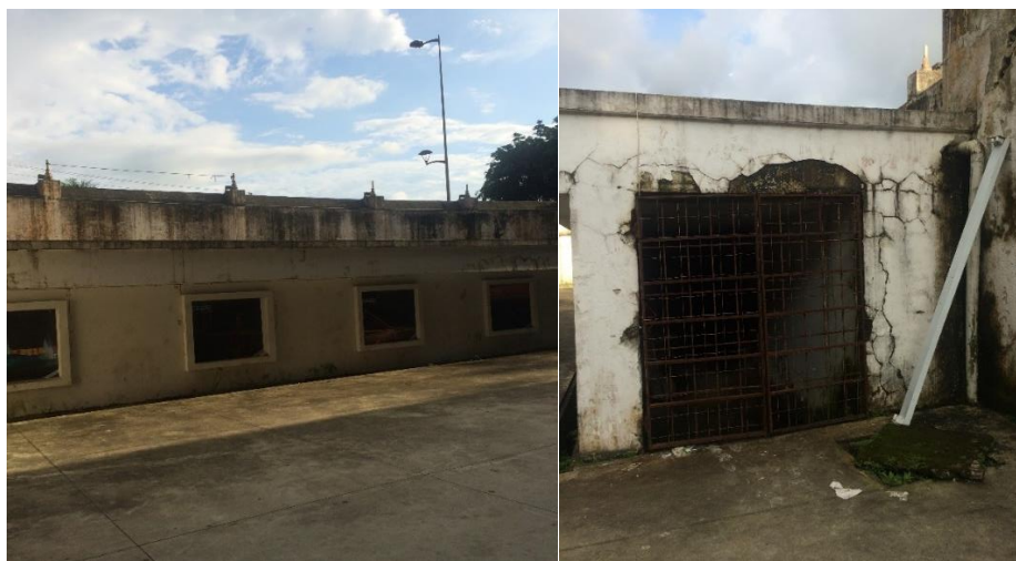
Figura 10. Bodega de almacenaje
