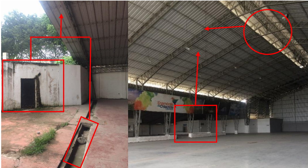
Figura 88. Espacio interior de la Nave central
