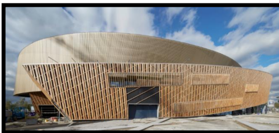
Figura 48. Exterior de la Fachada Mons International
