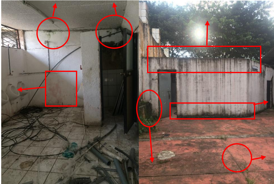
Figura 89. Área de baños
