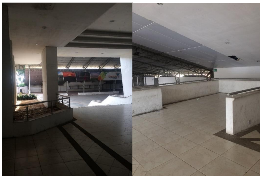
Figura 7. Espacio de concentración y escaleras
