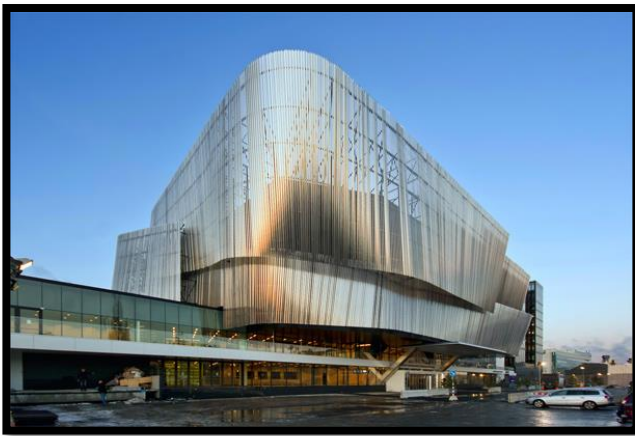
Figura 31. Exterior lateral Derecho
