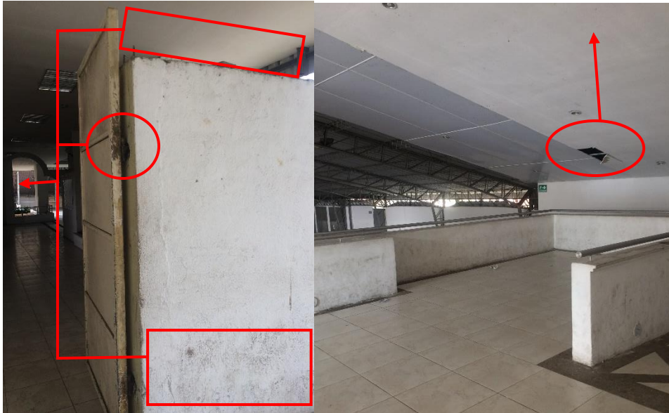
Figura 86. Ingreso principal y espacio de recibidor
