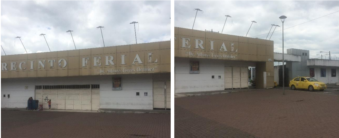
Figura 2. Entrada Principal peatonal
