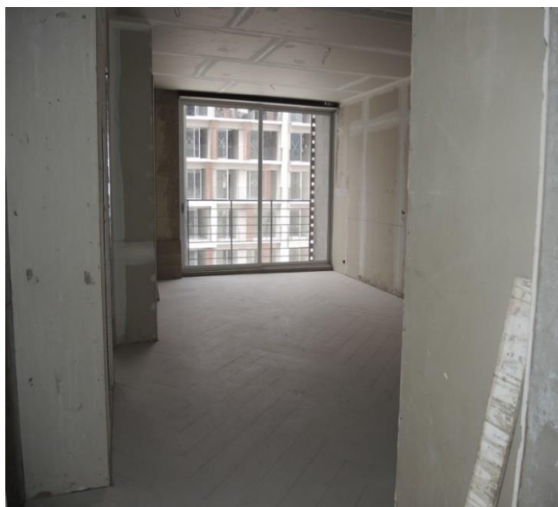
Figura 7. Pared mampostería con enchape de gypsum ( Tomado de: ( Yoo Cumbaya)
