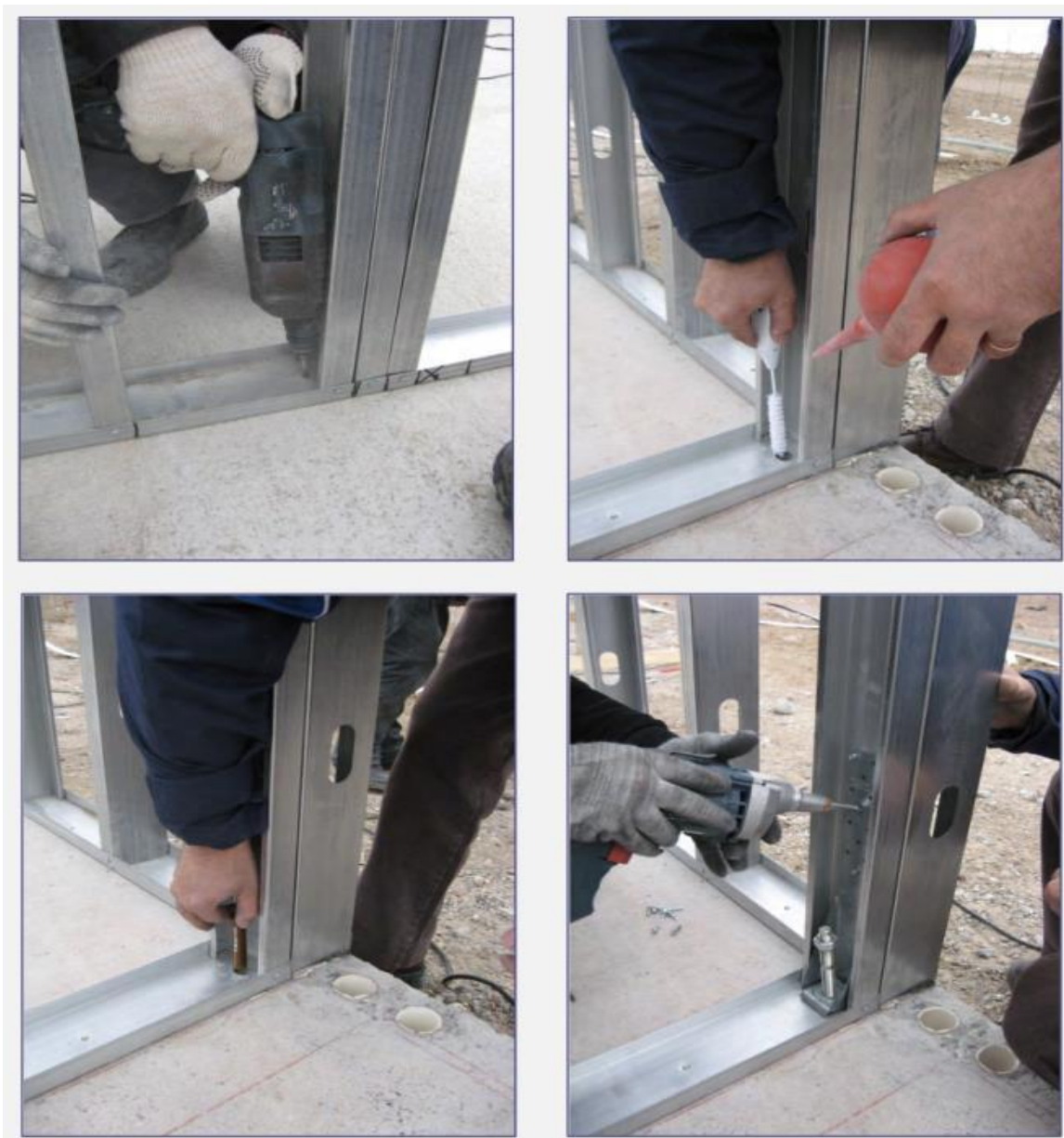
Figura 19: Colocación de anclajes y sujeciones de estructura al piso Tomado de: (Proyecto Yoo Cumbaya)
