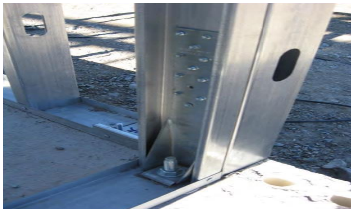
Figura 20: Fijación de conector hacia el piso. Tomado de: (Proyecto Yoo Cumbaya)
