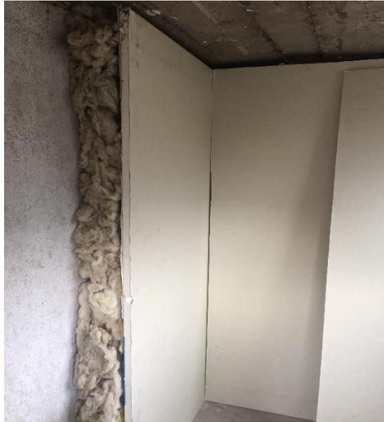
Figura 30 Pared con aislante y recubrimiento de gypsum
