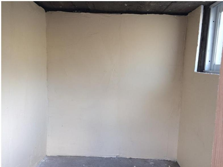
Figura 31 Pared con aislante, gypsum, estuco y pintura
