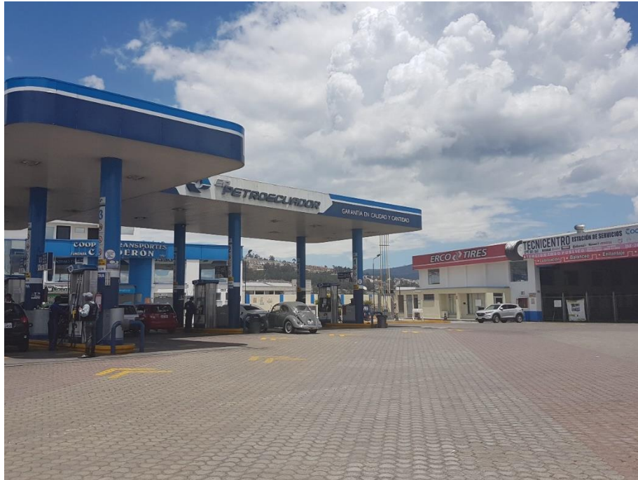
Figura 30. Estación de servicio y zona industrial Cooptracal S.A.
