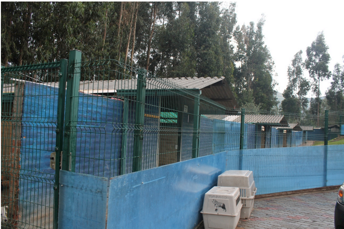
Ingreso a zona de caniles (espacio cercado donde habitan los perros).
