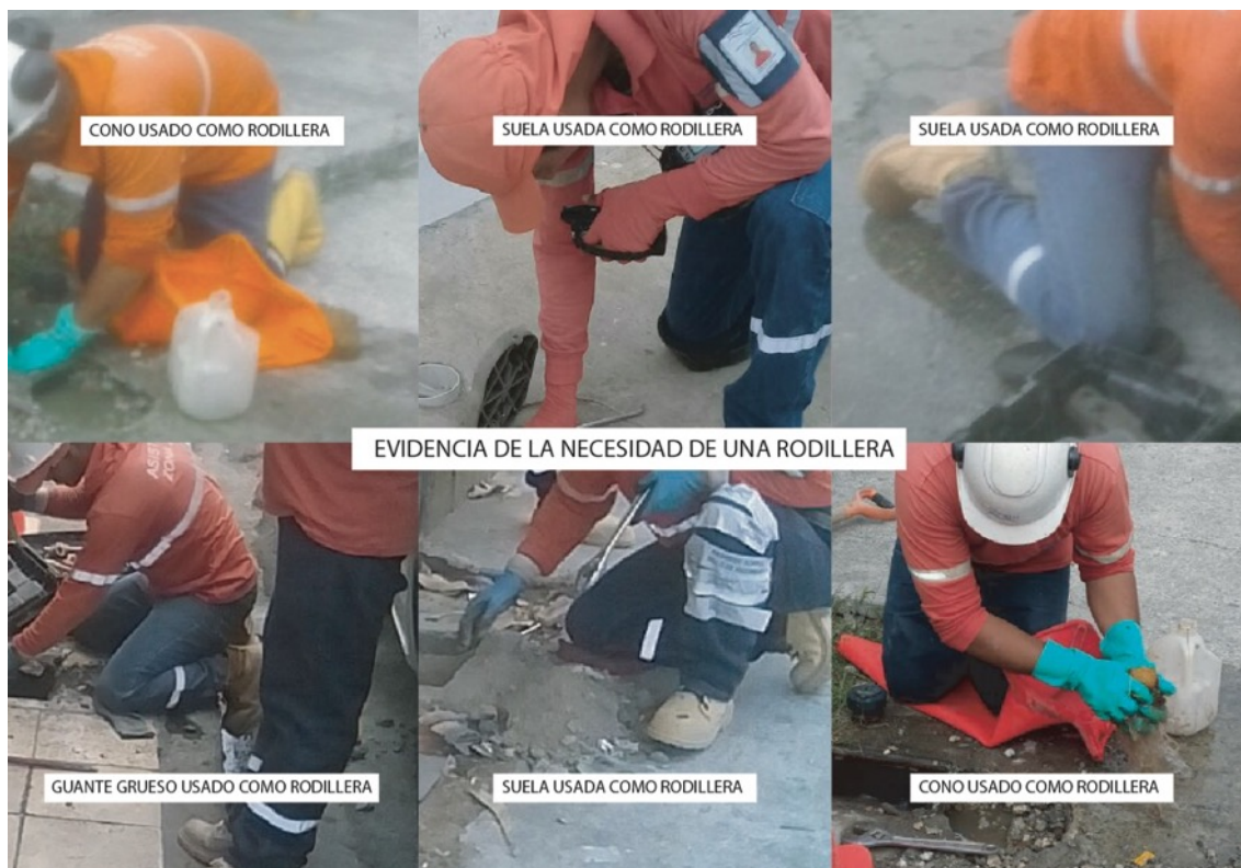
Figura 31. Evidencia de la necesidad de una rodillera.
