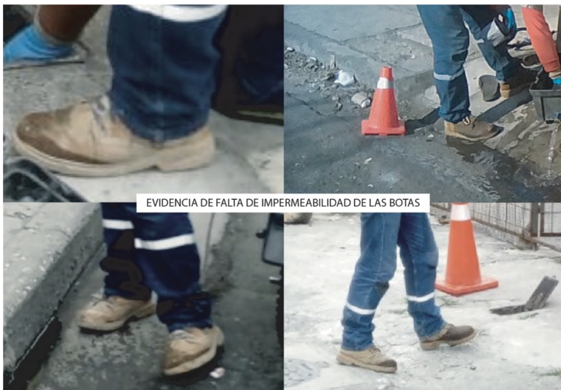
Figura 29. Evidencia de falta de resistencia de las botas al agua.
