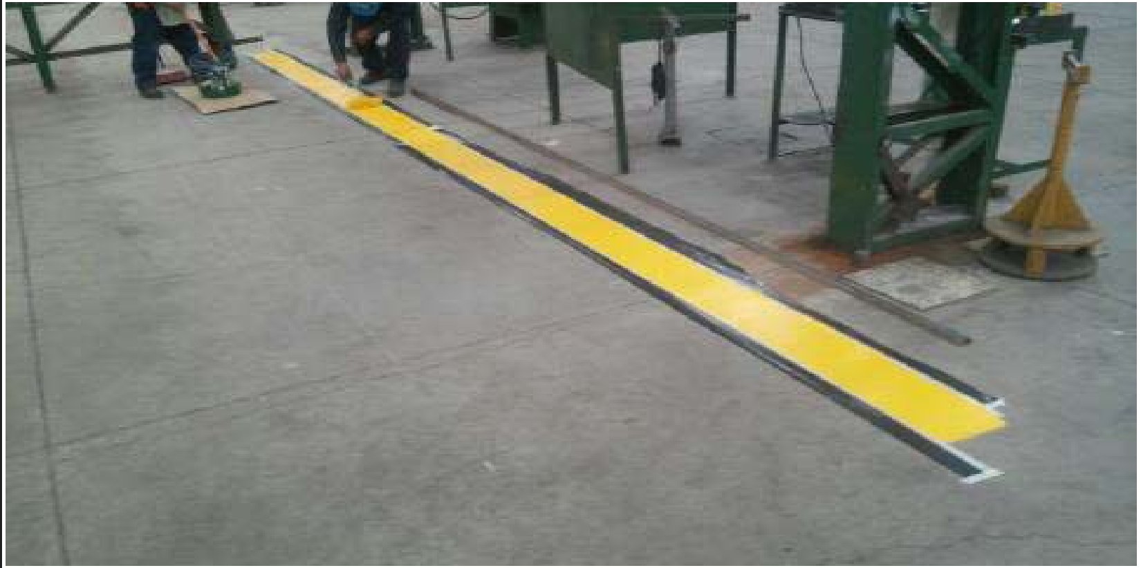
Pintura de Señalética de Planta.
