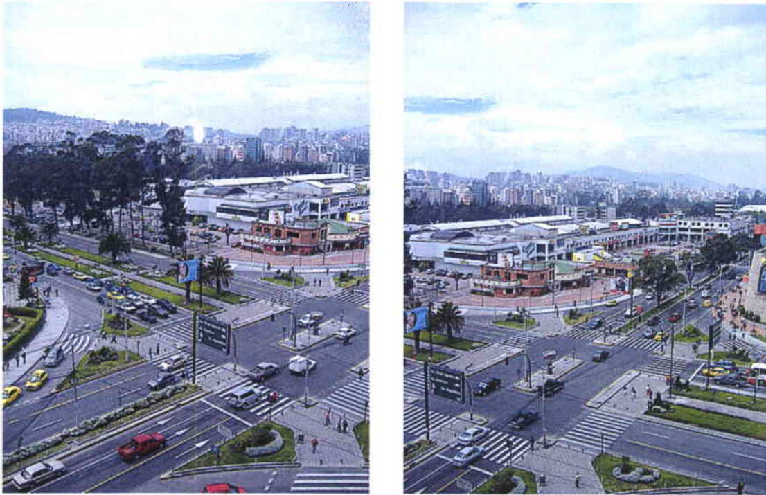
Intersección Av. Amazonas y Av. Naciones Unidas
