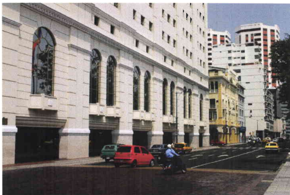
Vista a la calle 9 de Octubre
