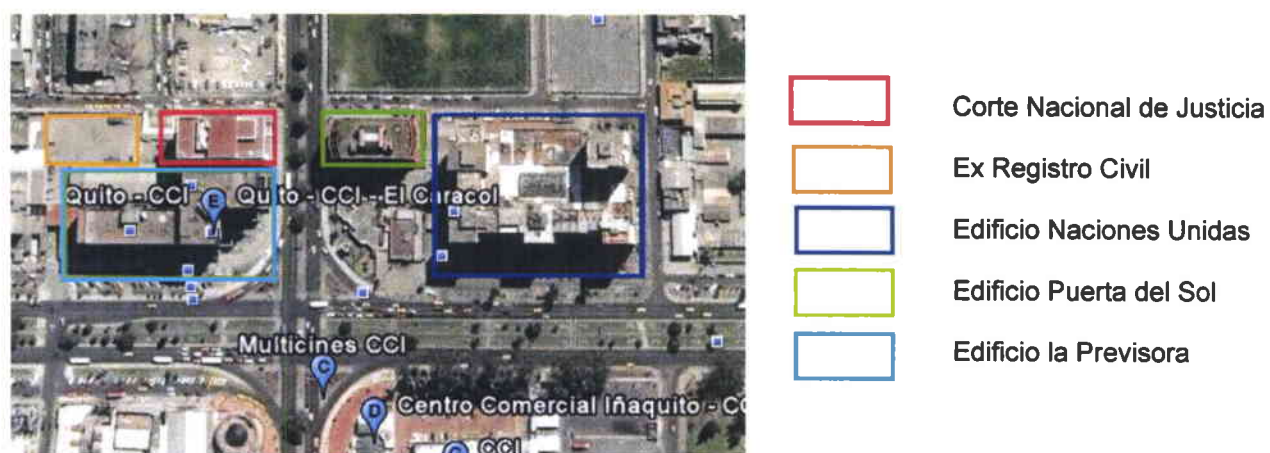
Fotografía aérea intersección Av. Amazonas y Naciones Unidas
