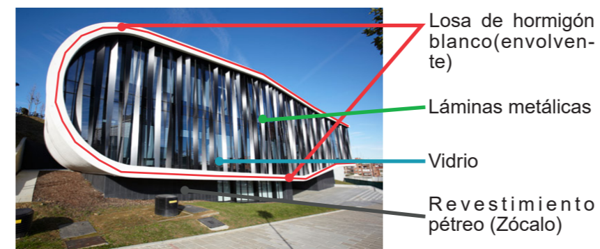
Figura 35. Materialidad en fachada frontal Tomado de Asga Arquitectos
