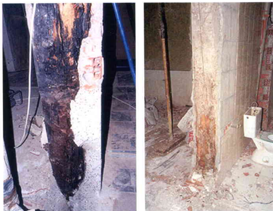
Ilustración 23. Estado previo de pies derechos
