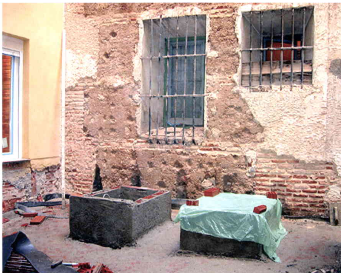
Ilustración 9. Fase de picado y recubrimientos, Patio Interior – Estado previo a la actuación
