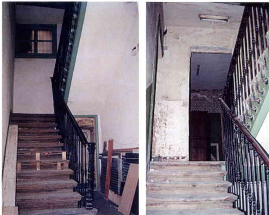
Ilustración 6. Escaleras – Estado previo a la actuación
