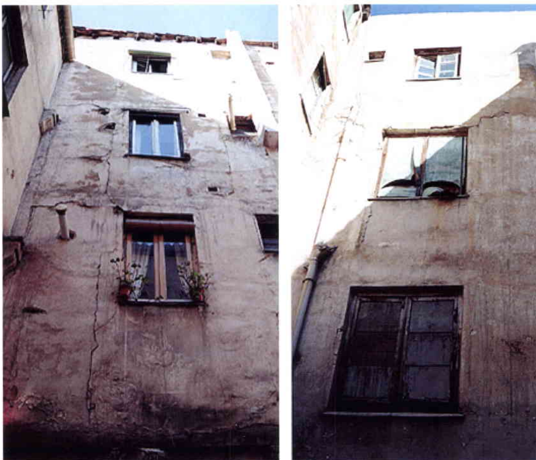
Ilustración 5. Patio Interior – Estado previo a la actuación
