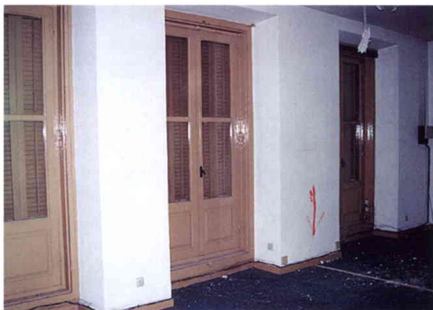
Ilustración 7. Escaleras – Estado previo a la actuación
