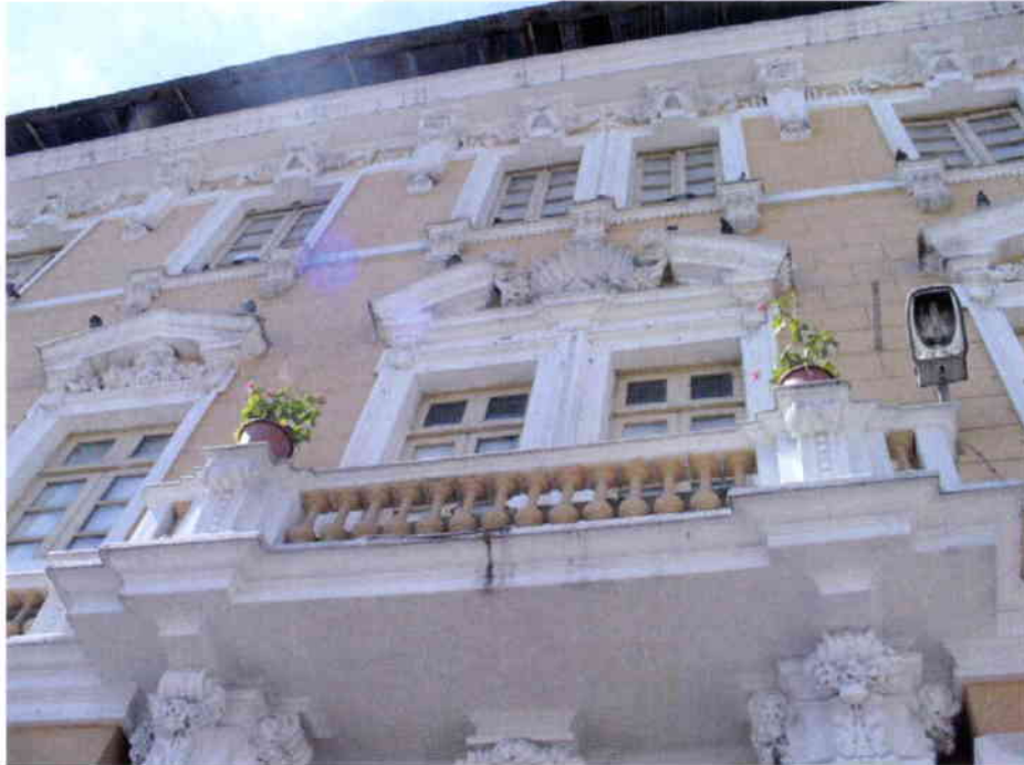
Fachada – balcones y ventanas
