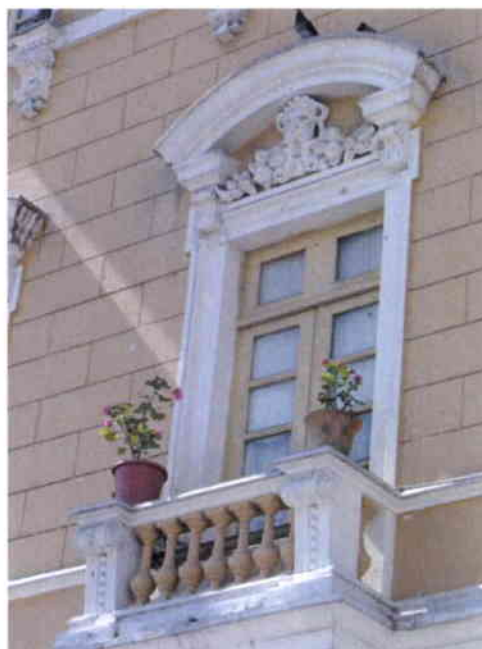
Fachada – Detalle de ventana
