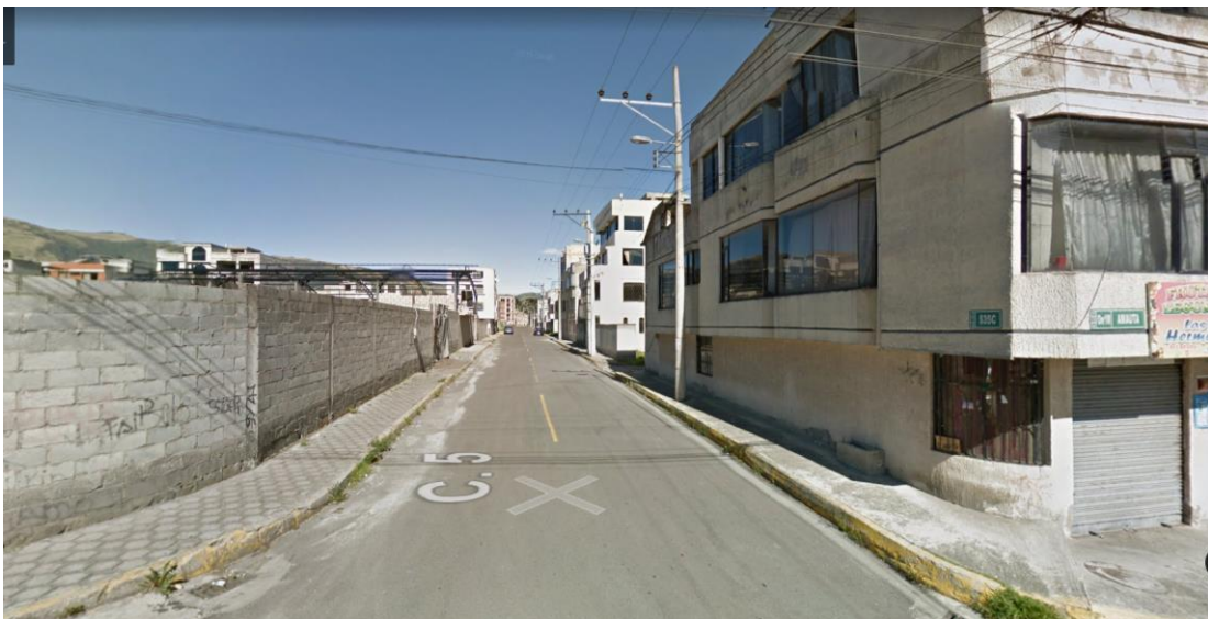
Figura 6. deterioro del aspecto físico y baja calidad de materiales para confort higrotérmico (Google maps,2022)
