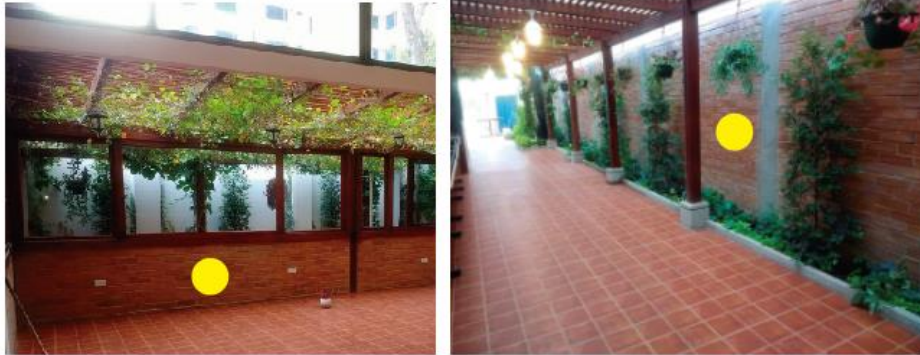
● Mampostería de ladrillo macizo visto
