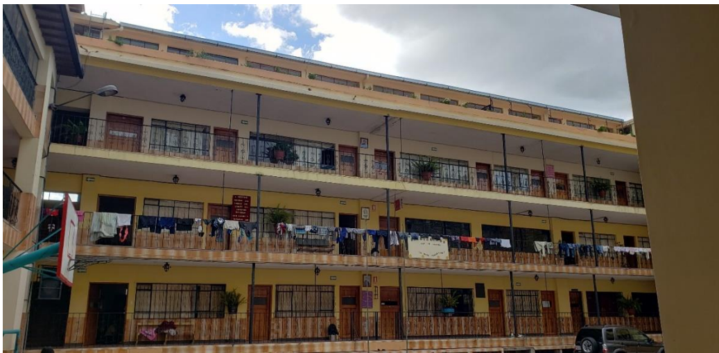
Figura 12. Instalaciones internas de la Casa de Acogida
