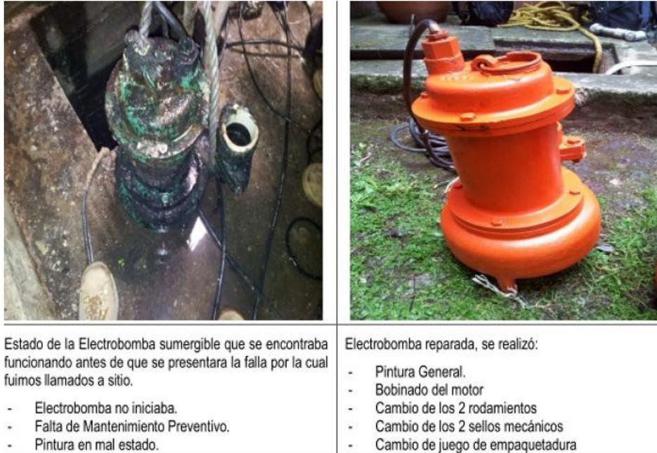
*Figura 105.* Mantenimiento de bombas sumergibles
