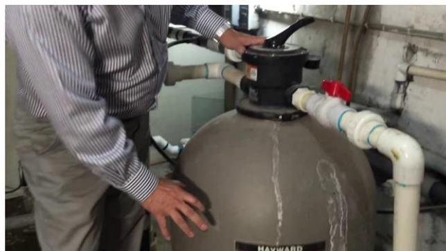
*Figura 107.* Mantenimiento de filtros
