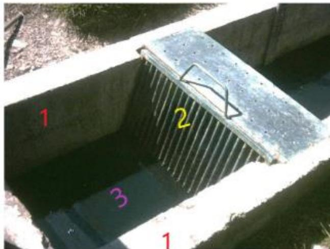
*Figura 17.* Rejilla media con lámina perforada para escurrimiento del material extraído
