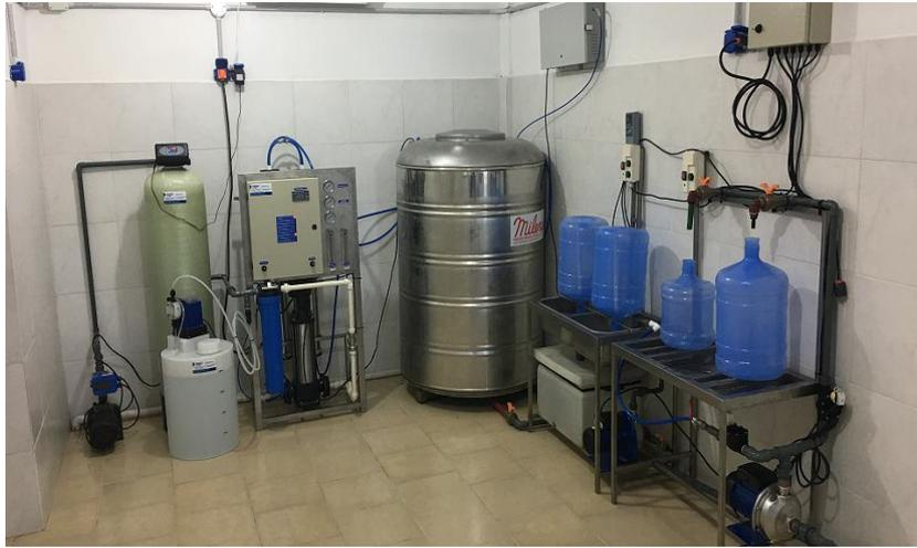
*Figura 84.* Planta purificadora de agua.
