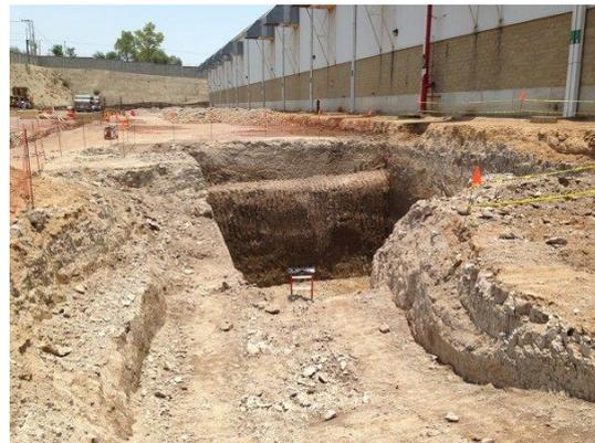
*Figura 56. excavaciones para tanques de almacenamiento de agua pluvial*
