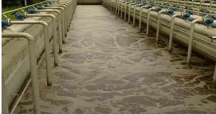
*Figura 69.* Tanque de aireación
