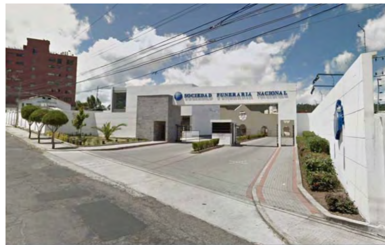
Figura 134. Imagen Vista Ingreso calle de las Buganvillas
