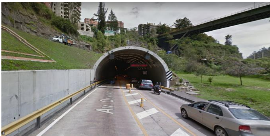
Figura 8. Entrada Centro Norte- Sector Bellavista.
