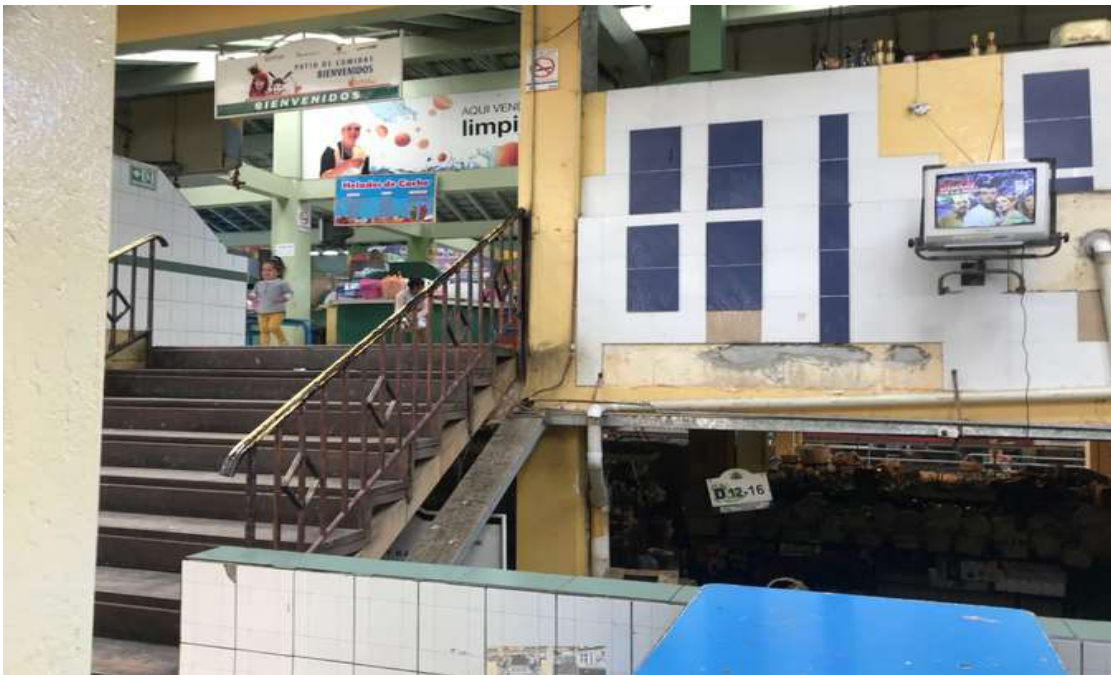
Figura 23: Escaleras estructura de metal y madera.
