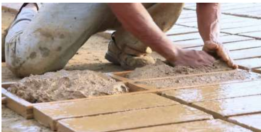
Figura 151: Trabajando con adobe.
