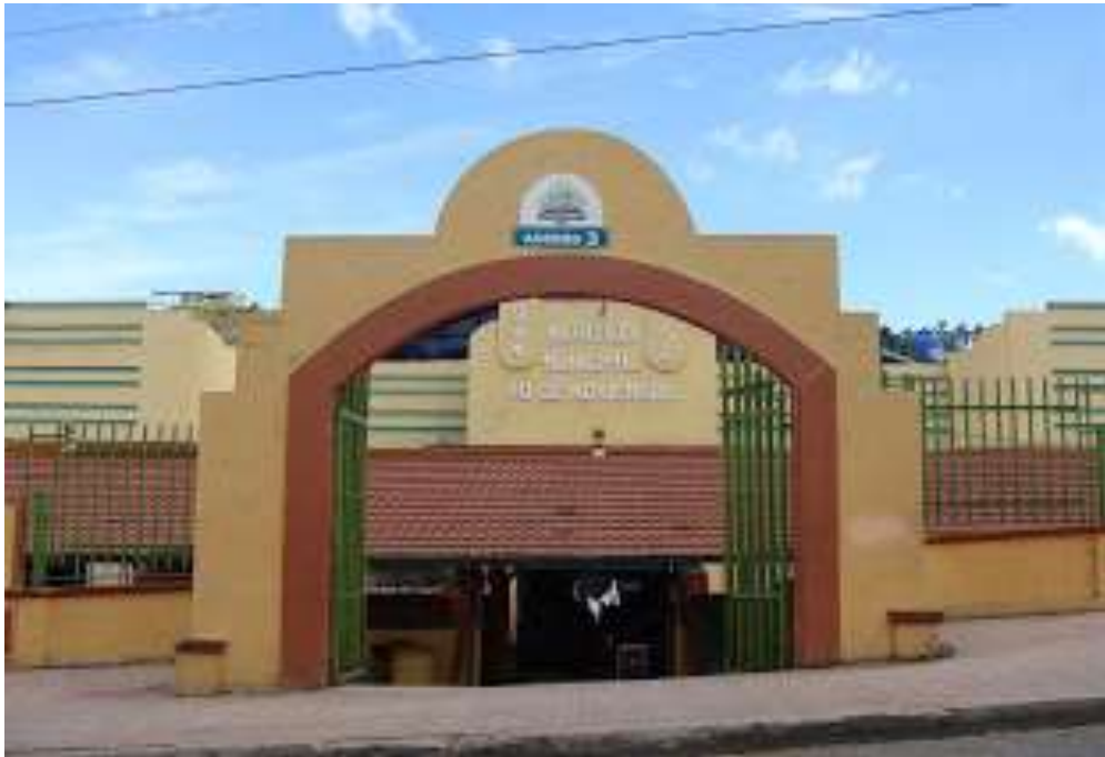
Figura 6: Vista de fachada desde la calle Convención de 1884.
