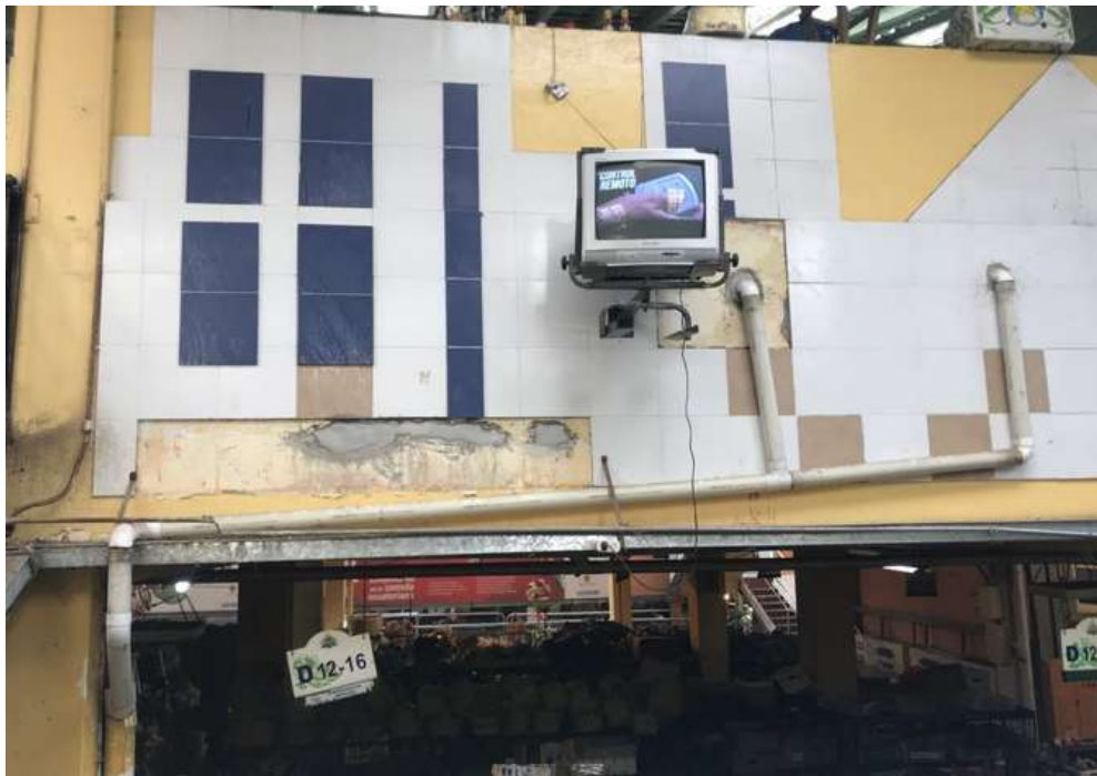
Figura 22: Tuberías a la vista de todos
