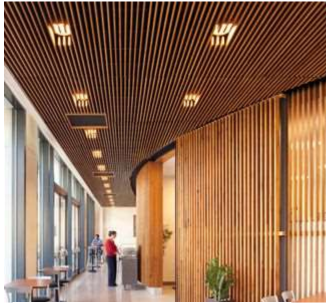
Figura 49: Cielo raso de paneles de madera Fuente: Adaptado de Ccorahua (2016)
