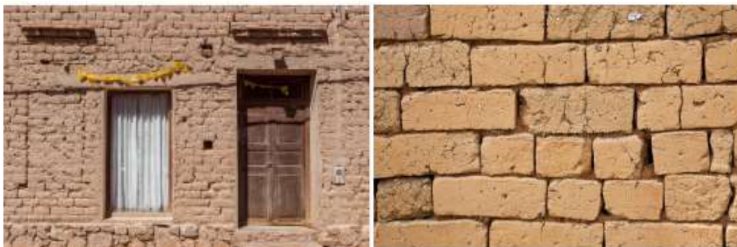
Figura 50: Paredes de ladrillos de Adobe Fuente: Vázquez (2018)
