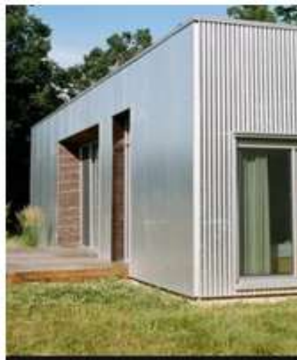
Figura 52: Paredes de zinc metálico Fuente: Vázquez (2018)
