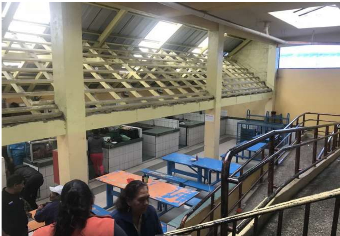
Figura 11: Vista patio de comidas y rampa.
