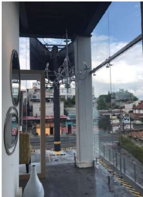
Figura 7. Ventanas de la fachada frontal.
