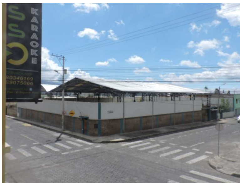
Figura 55. Vista desde primera planta
