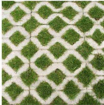
*Figura 52.* Modelo de adoquín ecológico instalado en el parqueadero
