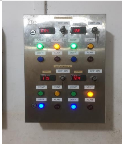
Control de Temperatura de Cámaras de refrigeración.
