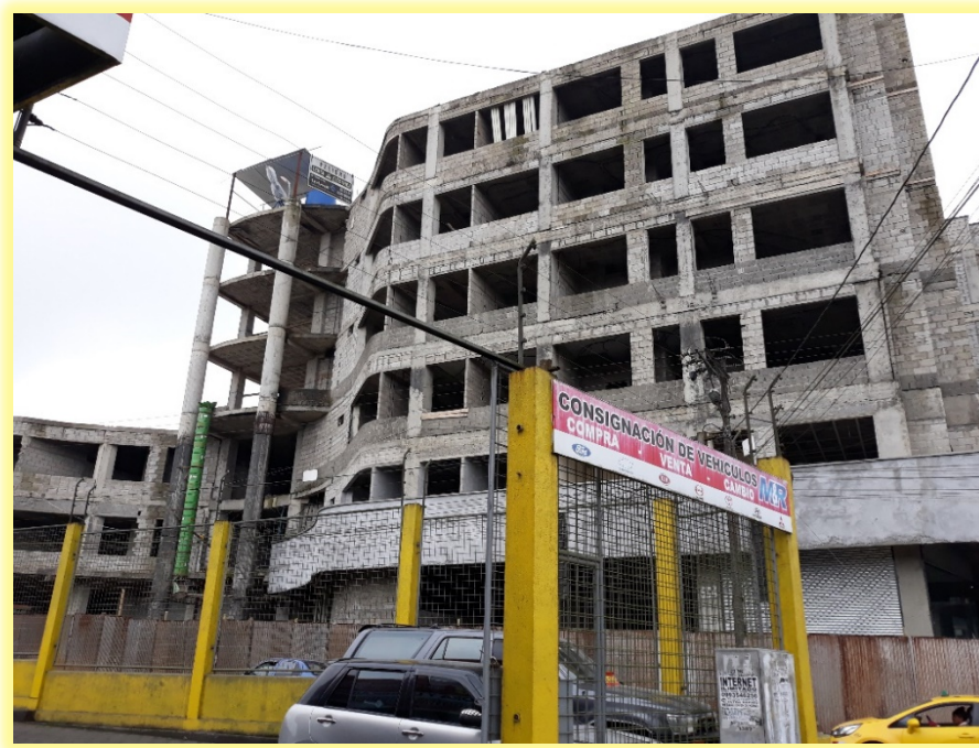
Figura 50, Visual externa hacia la fachada lateral izquierda del edificio Torres Zermatt.
