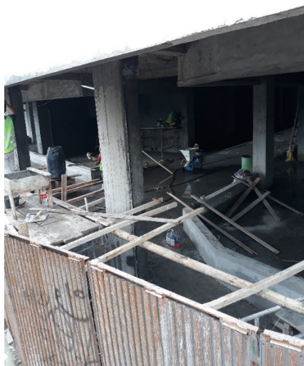
Figura 60, Avances de construcción en planta baja.
