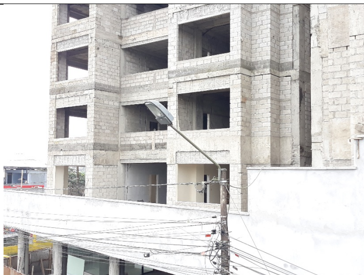
Figura 61, Enlucido y pintado de paredes de habitaciones internas en pisos superiores.
