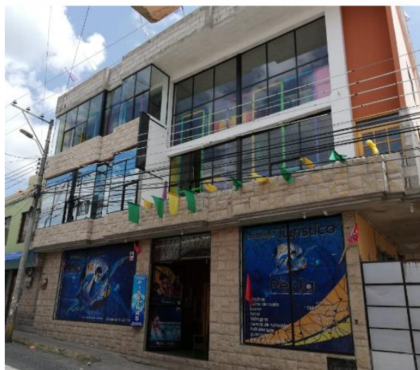
Figura 4. Fachada Frontal Complejo Perla.
