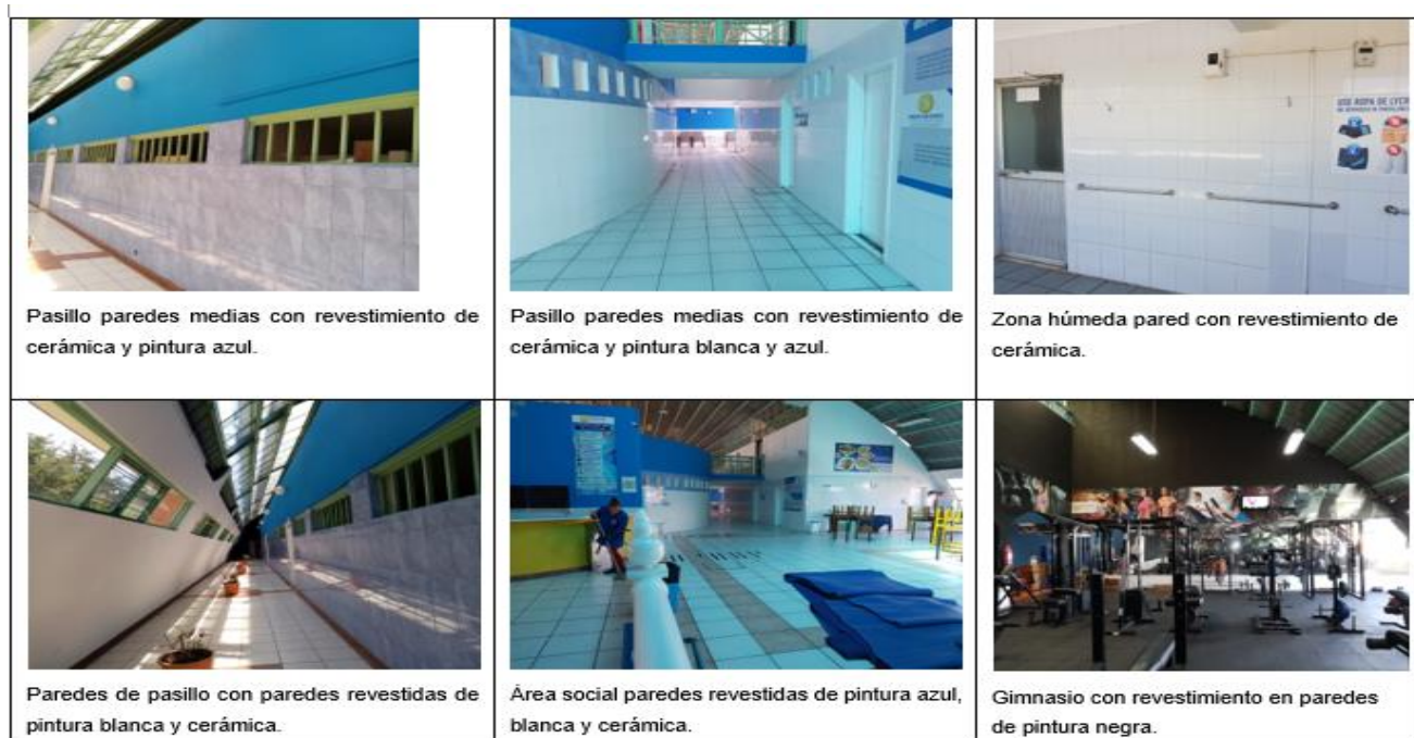
Figura 62: Paredes existentes en el proyecto
