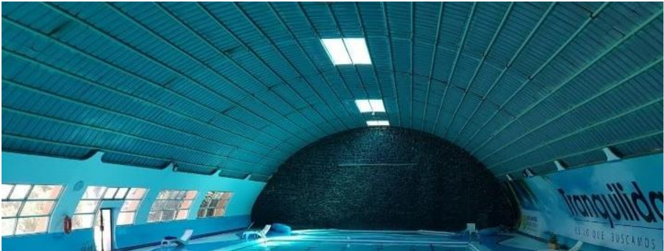
Figura 56: Vista interior de la estructura del galpón
