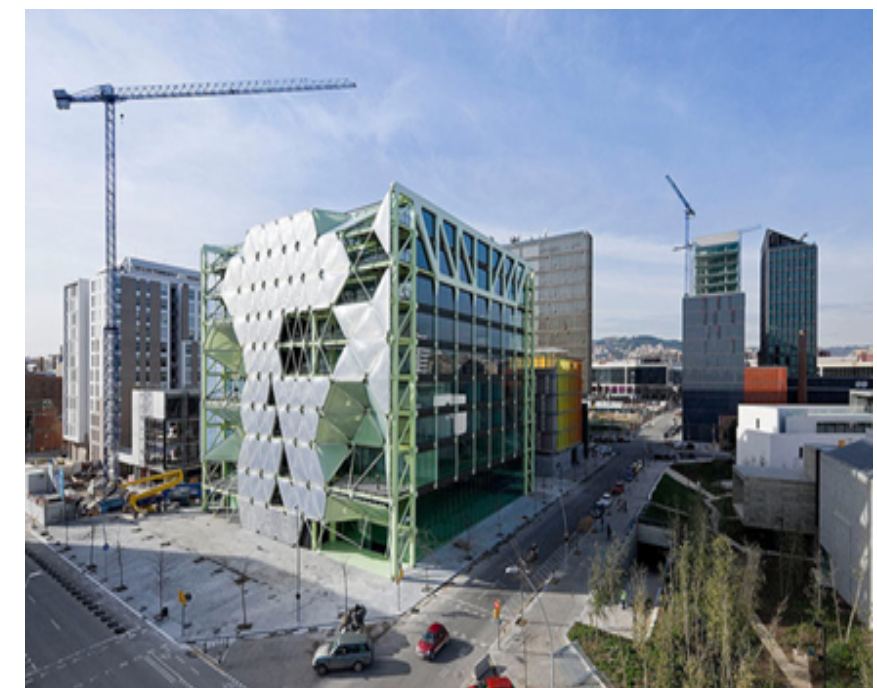
Figura 43. Edificio Media Tic Tomado de (Plataforma arquitectura, 2010)
