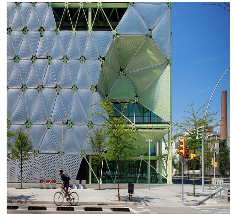
Figura 39. Edificio Media Tic Tomado de (Architecture now, 2011)
