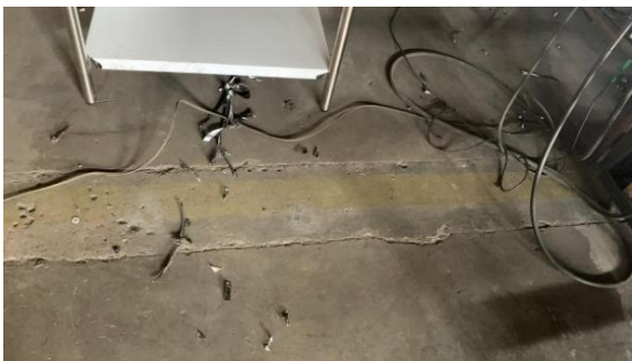
Figura 64. Pedazos de acero en suelo.
