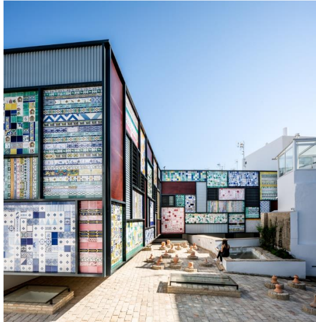
Figura 35. Exterior hotel. Tomado de (Plataforma Arquitectura, 2019)
