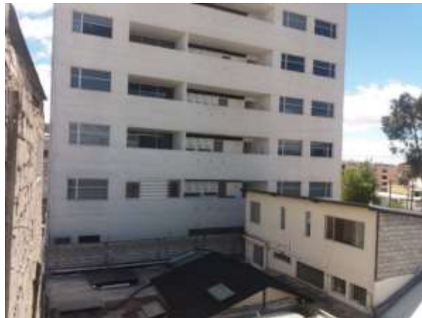
Figura 77 Vista frontal de la locación que se va a tomar.
