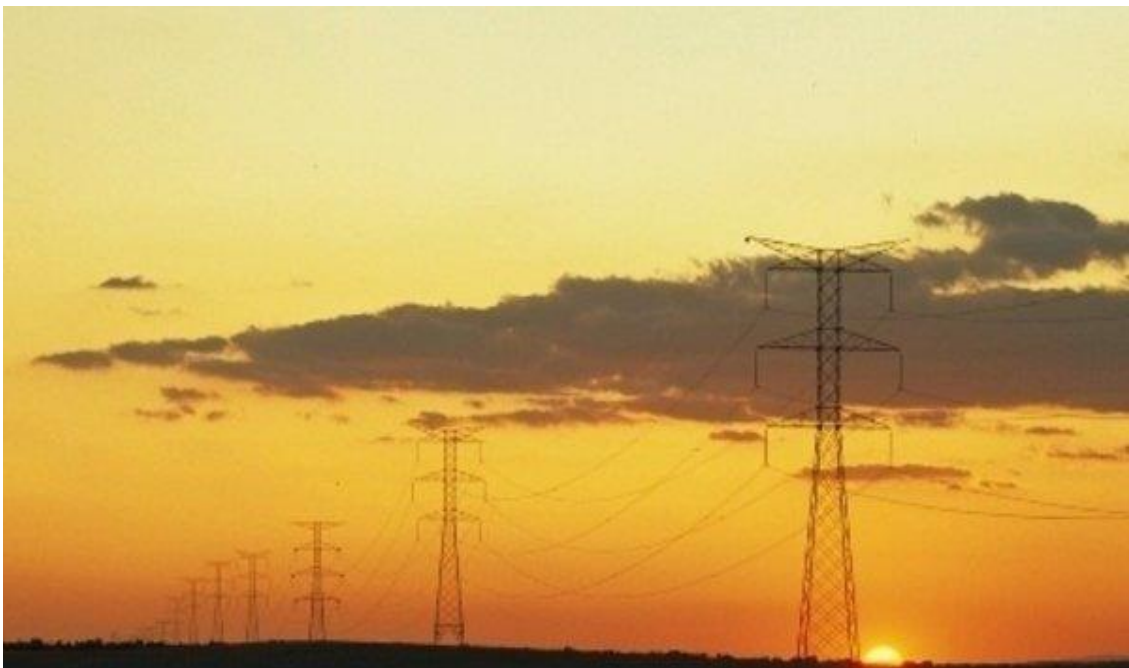
Figura 1. Línea de transmisión Milagro - Babahoyo a 230 kV
