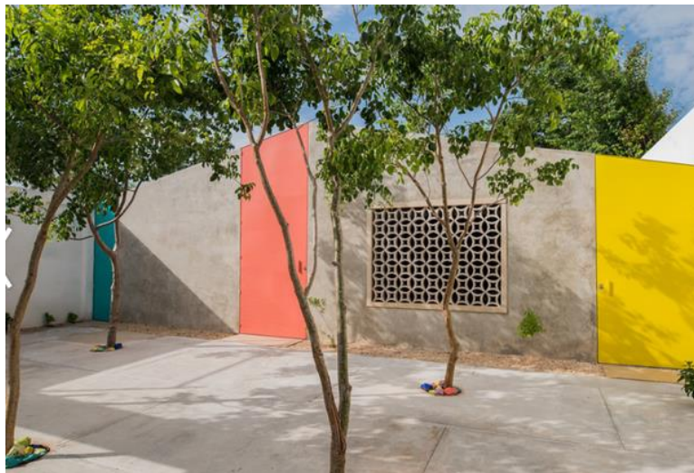
Figura 42. Fachada exterior de patio, Noon
