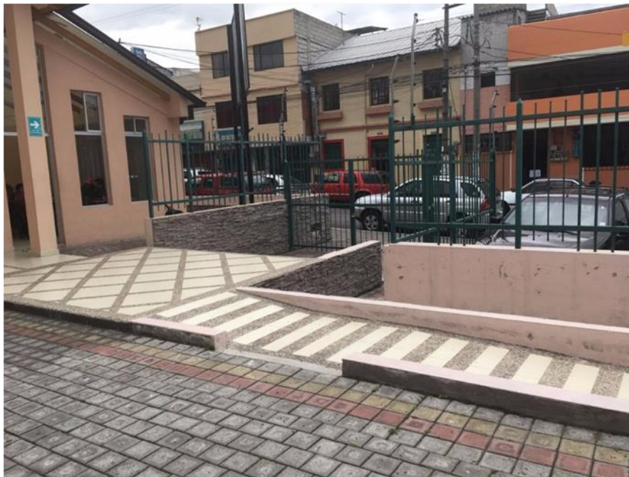
Figura 8. Acceso universal en el ingreso principal
