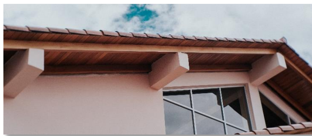
Figura 68. Recubrimientos cielo raso en exterior. CF.C.
