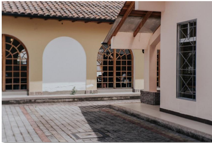
Figura 67. Edificación colindante. C.F.C.
