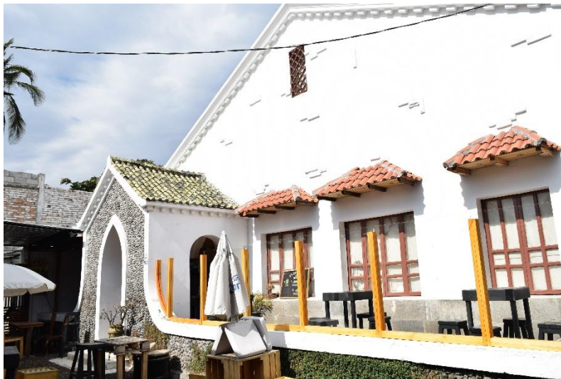
Figura 1. Fachada Principal de la casa lateral derecho.
