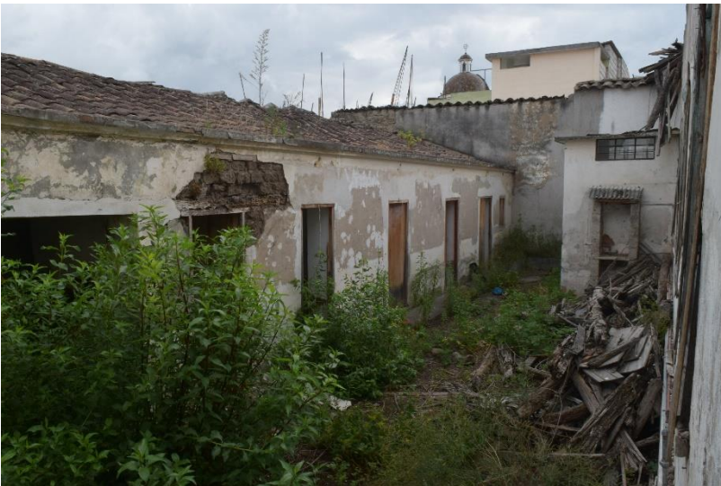
Figura 78. Patio Exterior Posterior.
