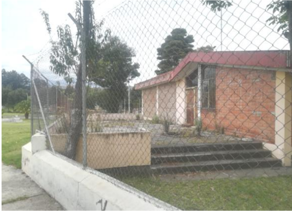
Figura 3. Exterior sin acabar
