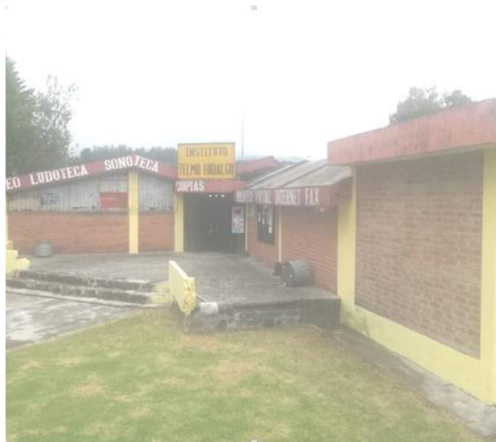
Figura 80. Parte de la mampostería, materiales y cubierta existente.
