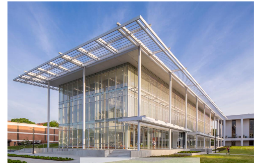
Figura 99. Fachada Watt Tomado de (Perkins+Will, 2015)
