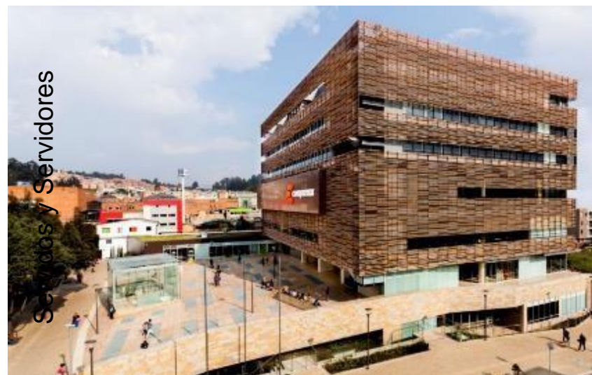
Figura 38: Compensar Sede suba. Tomada de (Plataforma de Arquitectura, s.f)
