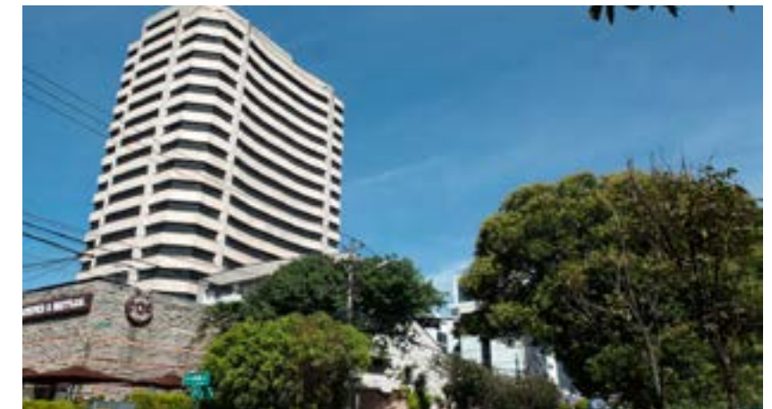
Figura 151. Edificio de Obras Públicas Adaptado de (Fotografía del Sector,2018)
