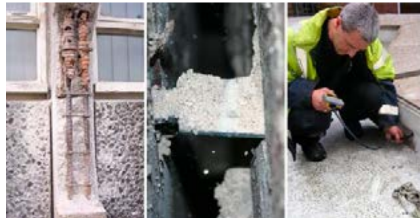
Figura 71. inspección de hormigón Tomado de (estudiosassani, 2018)
