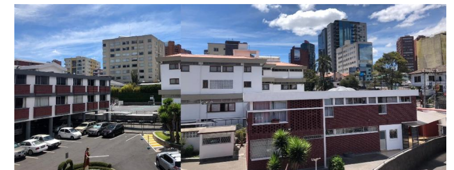
Vista hacia el terreno 1
