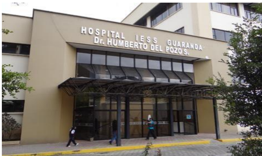
Figura 1: Fachada externa del Hospital Básico IESS - Guaranda
