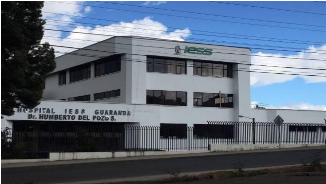
Figura 13: Instalación del Hospital Básico IESS – Guaranda Tomado de: Hospital Humberto Pozo (2016).
