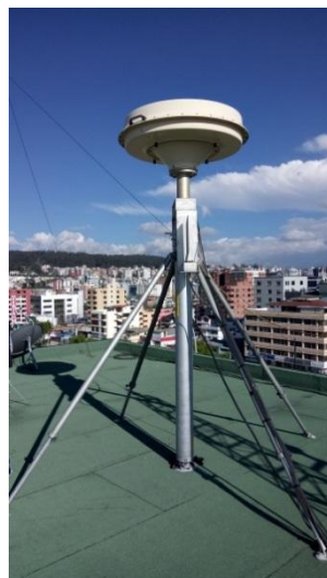
Figura 19. Antena R&S HE500 – Edificio Coordinación Zonal 2 ARCOTEL – Quito
