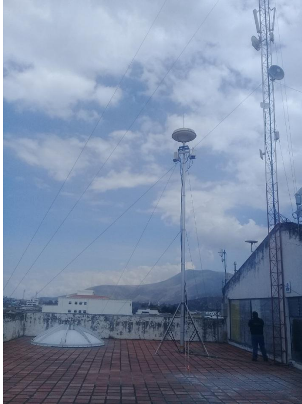
Figura 25. Antena R&S HE500 - Edificio del Gobierno Autónomo Descentralizado Municipal de San Miguel de Ibarra - Ibarra
